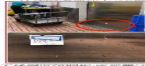
不銹鋼區隔門板底部髒汙
